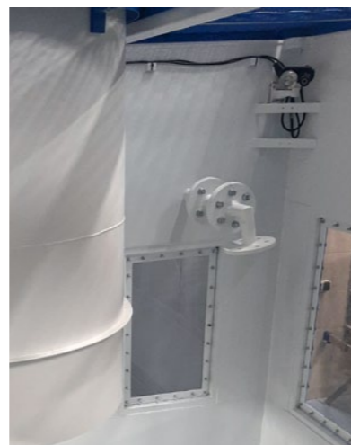
Конструкция трубопровода на стене бассейна
