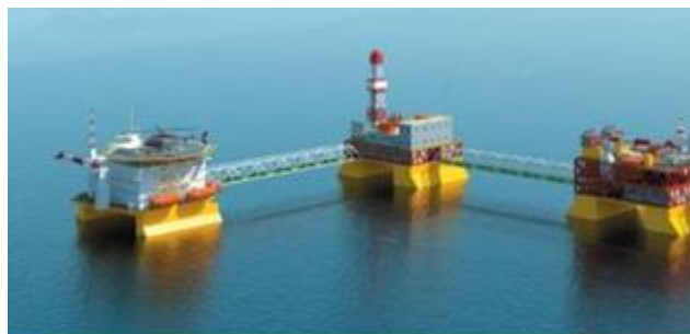
Во время проведения работ на водных-прибрежных объектах
